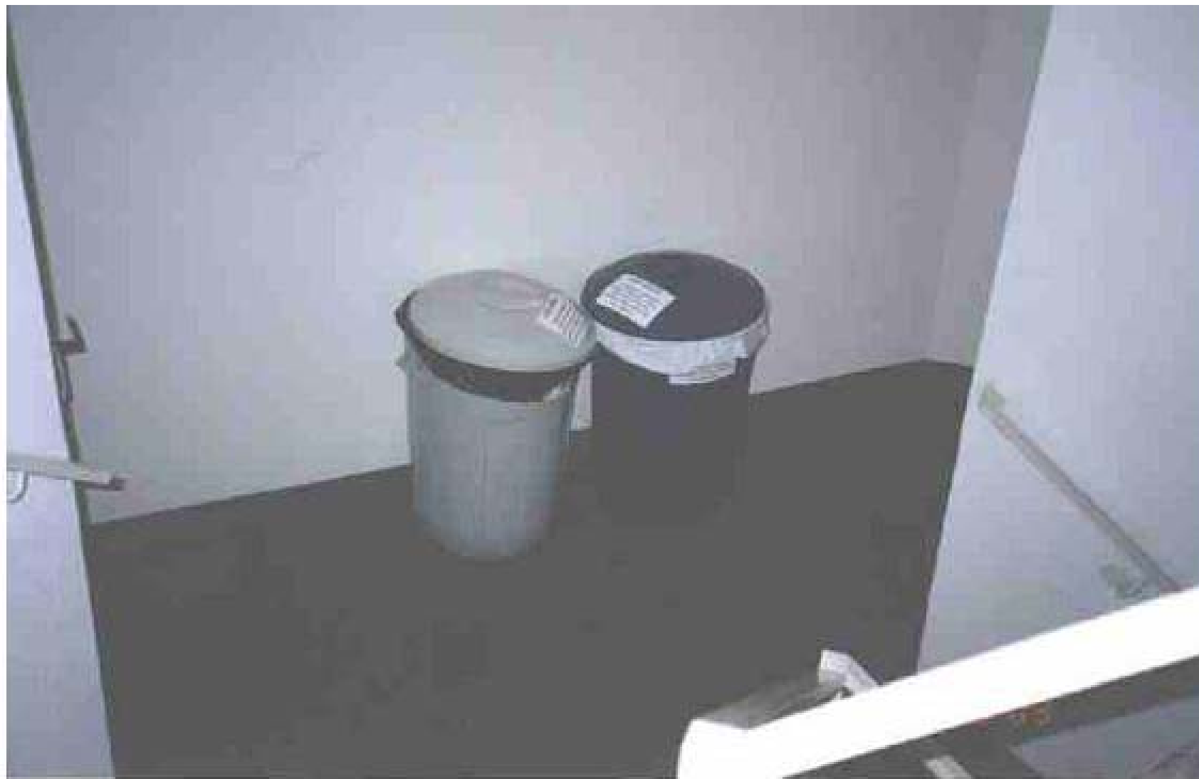
Foto 7 – Outra vista de outro edifício com rota de fuga obstruída pelas lixeiras.
