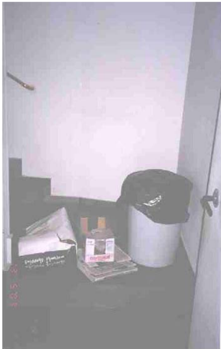
Foto 6 – Vista da escadaria e antecâmara de um dos edifícios, com a rota de fuga obstruída pelas lixeiras.
