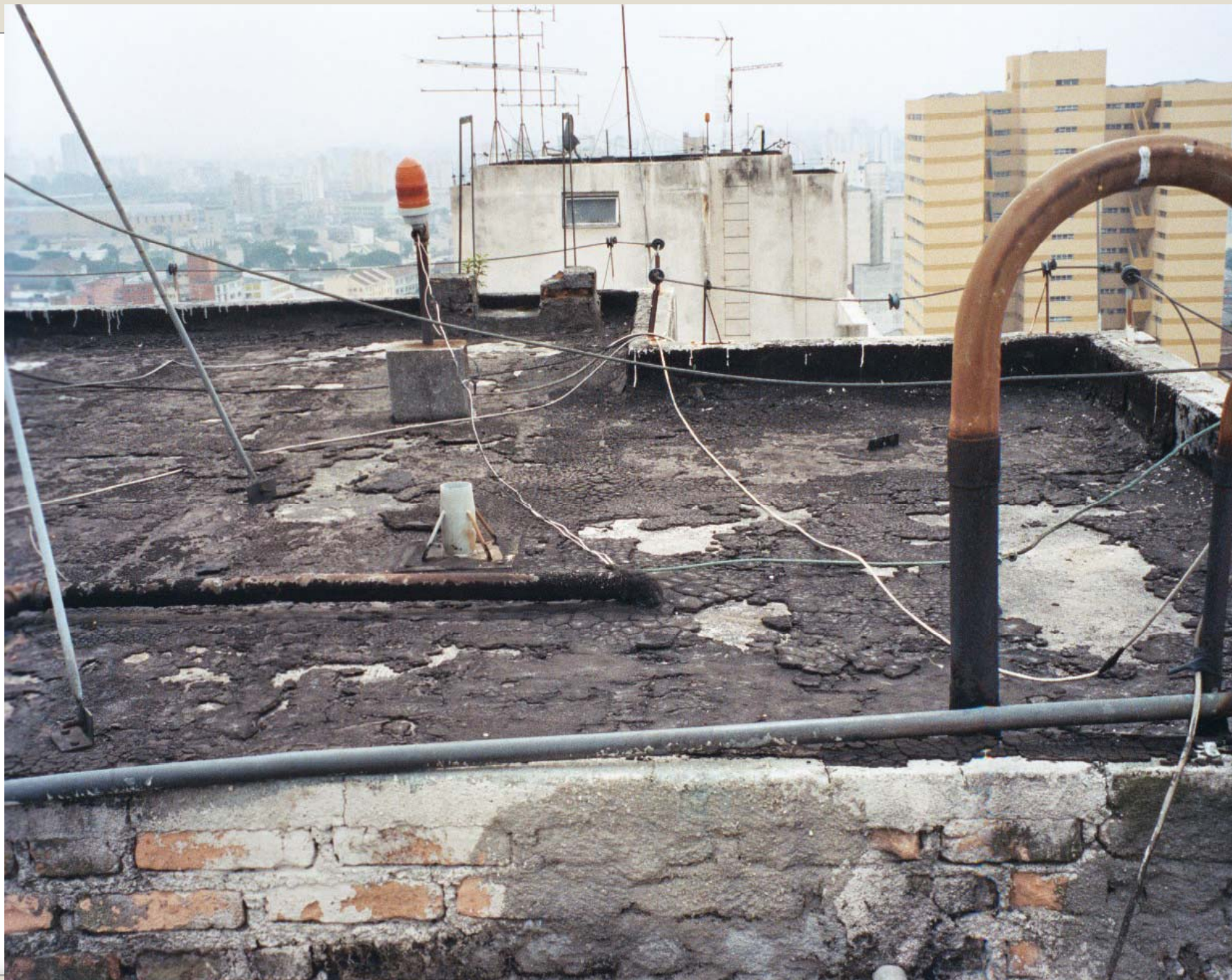
Apresentação da Câmara de Inspeção Predial do IBAPE/SP – set/2009
