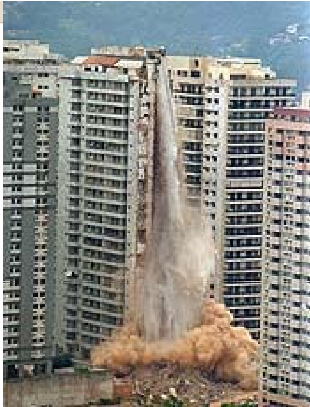
Apresentação da Câmara de Inspeção Predial do IBAPE/SP – set/2009
