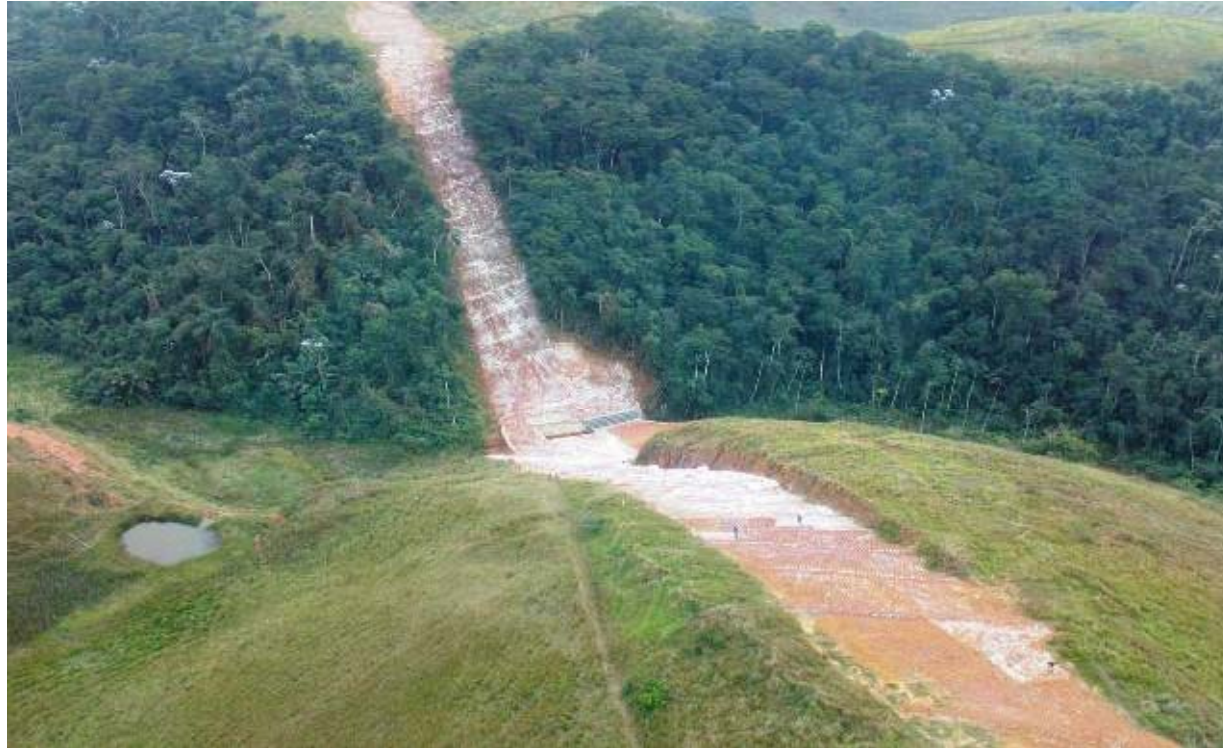
Abertura de Pista
